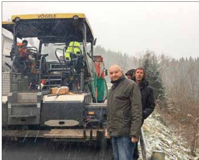
1. Bürgermeister Peter Ebertsch machte sich vor Ort ein Bild von den Asphaltierungsarbeiten.
